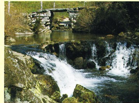
Ponte da Previsa
